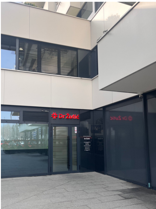
Gebäude von außen
